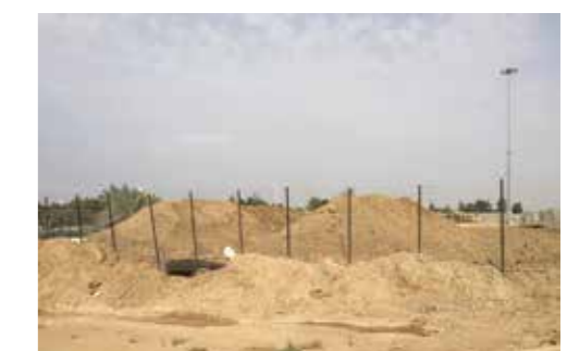
Navezené zeminy na biodegradační ploše
