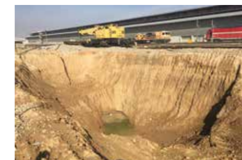
Výkop znečištěné zeminy
