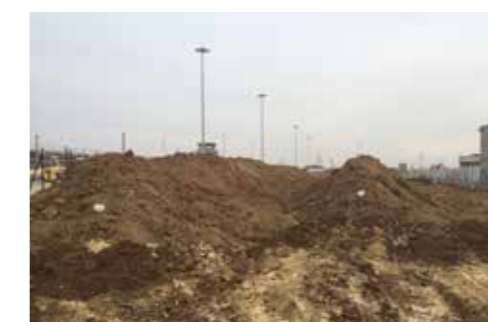
Výstavba dekontaminační plochy
